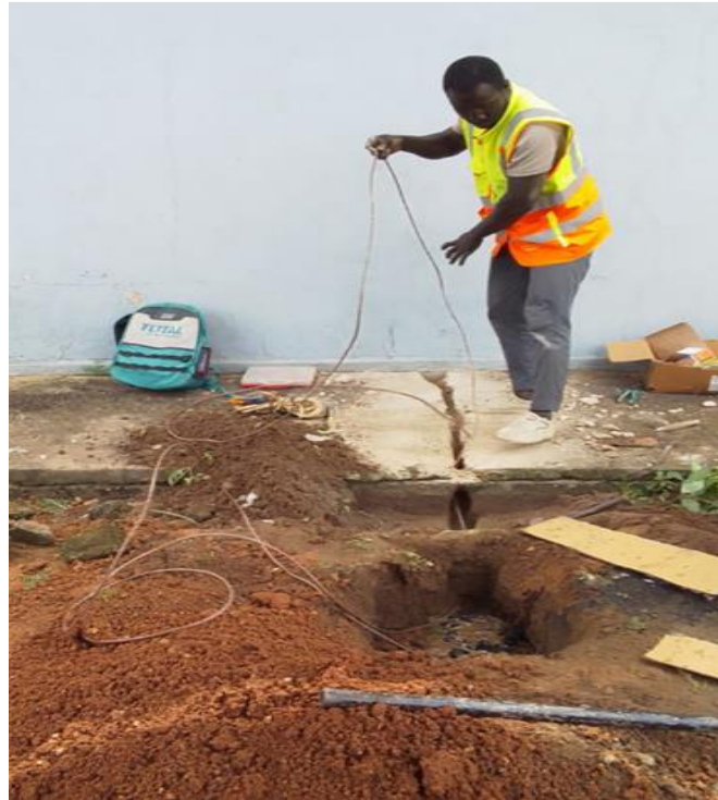
Travaux de forage et installation électrique – Touboro, 2025
